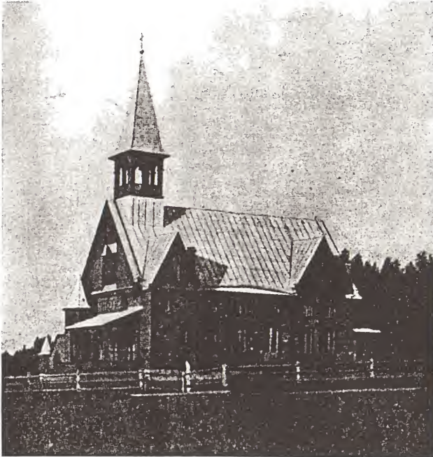
Haapakankaan kirkko. Rakennettu v. 1911. 450 istumapaikkaa.
